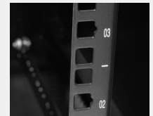
Perfiles de rack numerados
