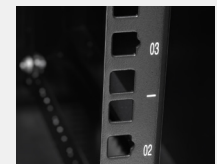
Perfiles de rack numerados
